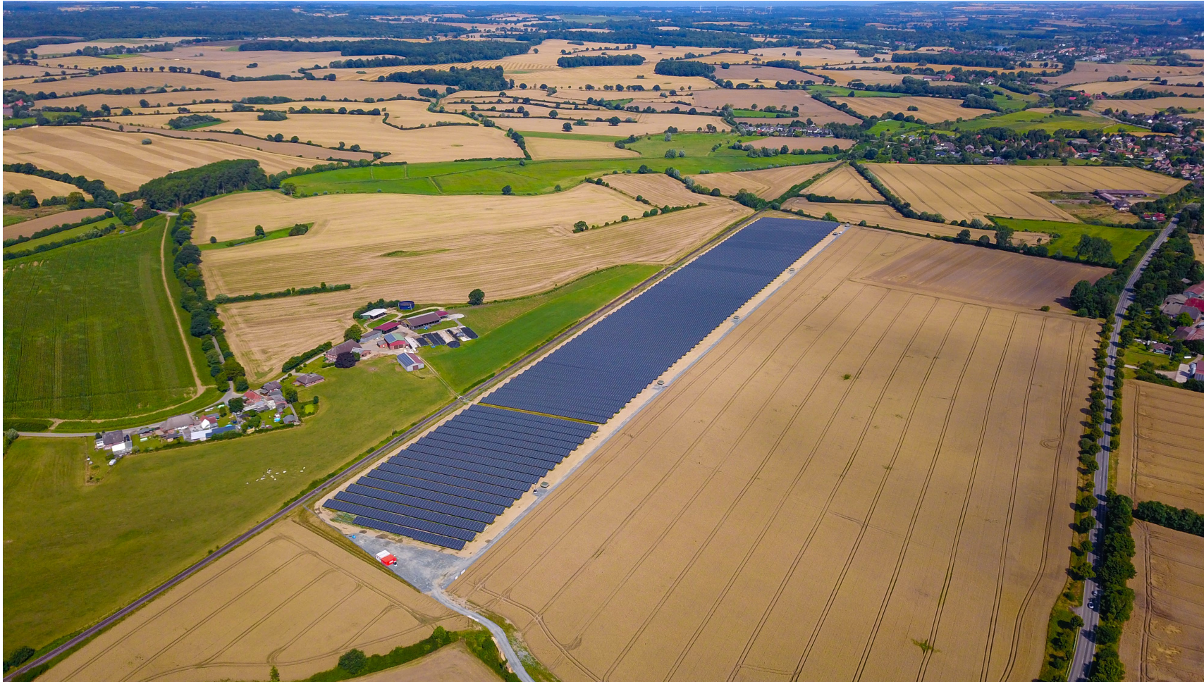
Solarpark Schlamin - 10 MWp Schleswig-Holstein
